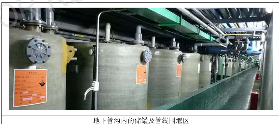
图 3-8 鹏鼎公司地下管沟现场踏勘照片
