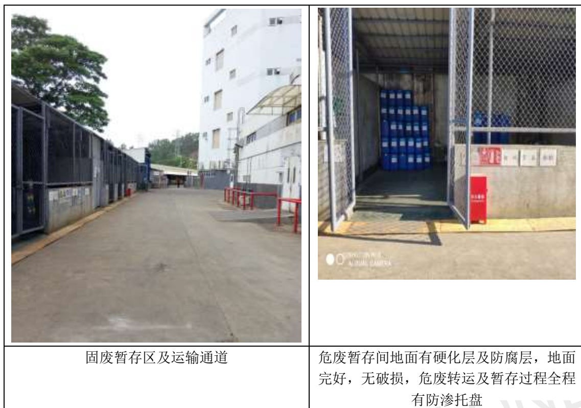
图 3-11 鹏鼎公司固废/危废暂存区现场踏勘照片
