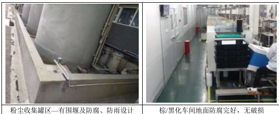
图 3-7 鹏鼎公司生产厂房现场踏勘照片
