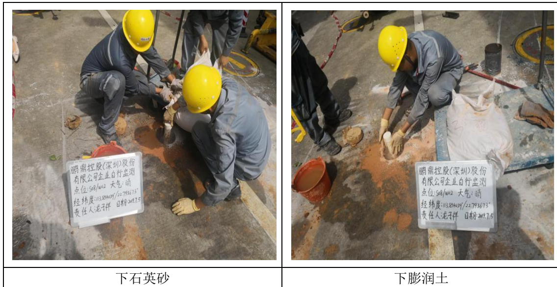
图 5-2 地下水监测井建设 (W02)
